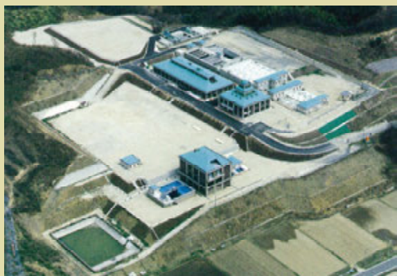
荒井浄水場(郡山市)
