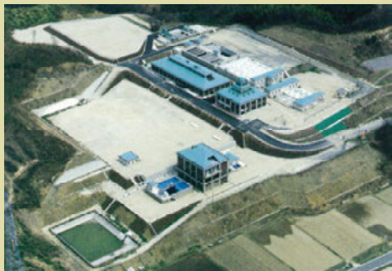
荒井净水厂 (郡山市)
