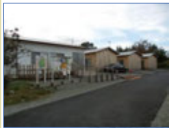
미하루댐 주변의 응급 가설 주택
